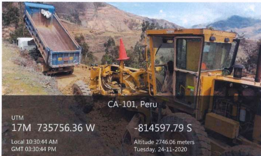
Fotografía 40. Motoniveladora realizando trabajos de extendido de material granular en la vía.
