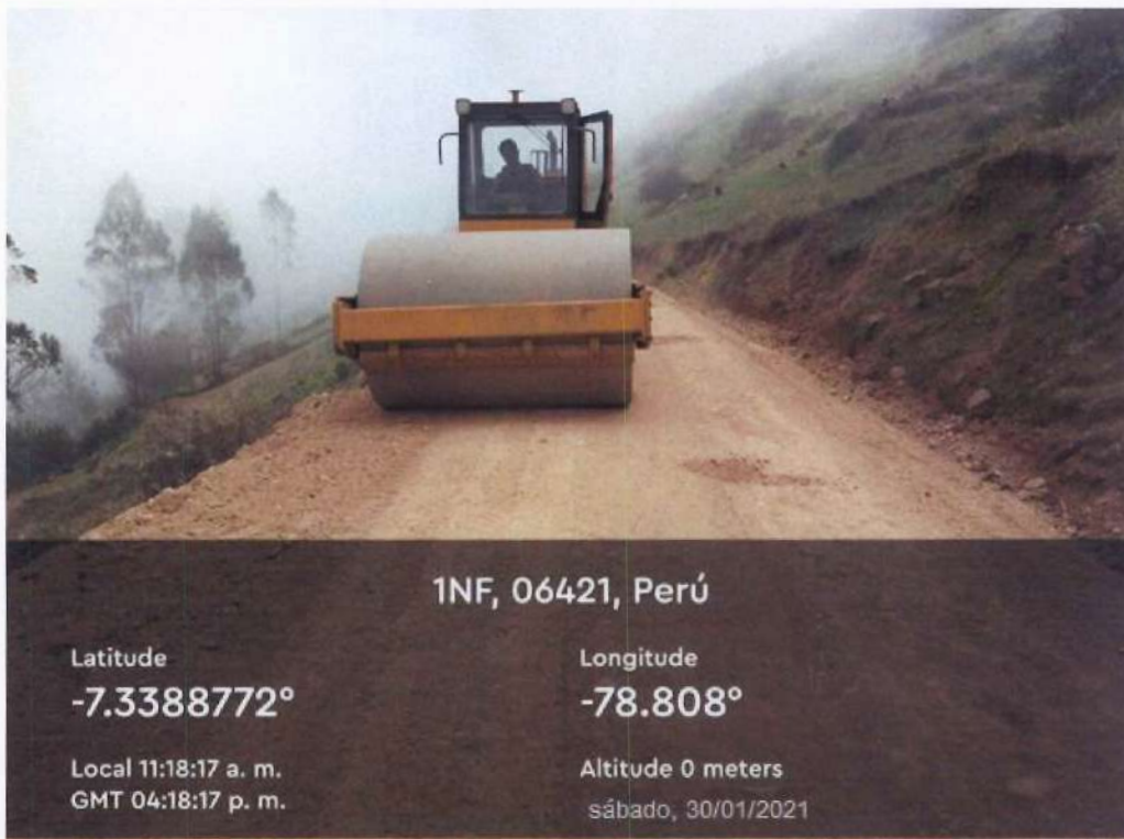
Fotografía 68. Rodillo realizando trabajos de compactación en la vía.
