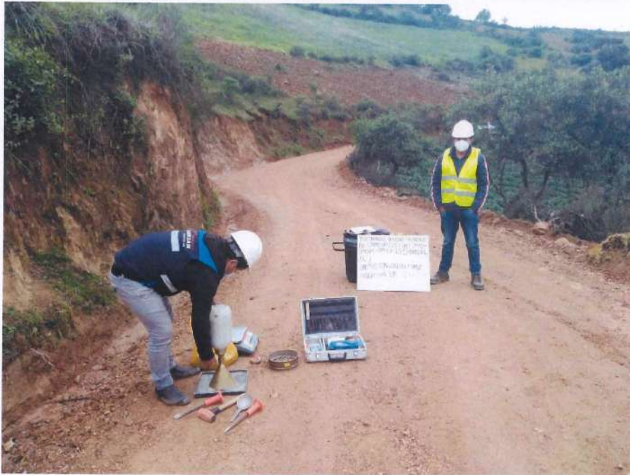
Fotografía 129. Densidad de campo el km 14+750.
