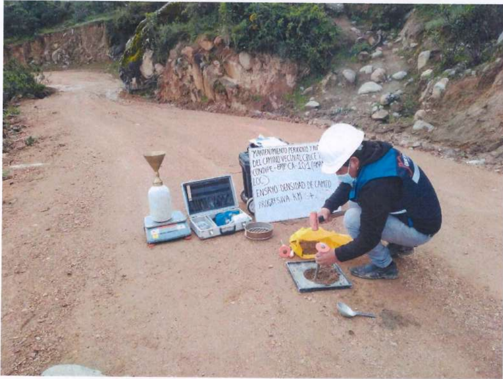
Fotografía 125. Densidad de campo el km 13+250.
