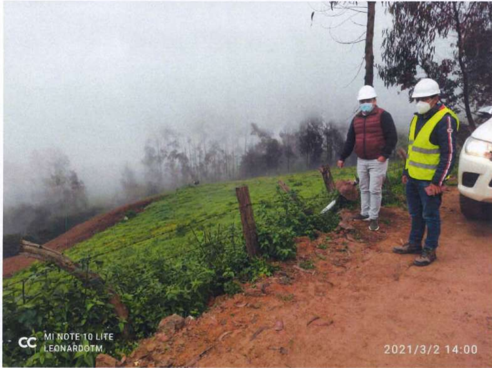
Fotografía 135. Verificación de los daños ocasionados a una señal reglamentaria por personas ajenas a la obra .
