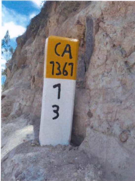
Fotografía 97. Instalación de hito kilométrico en KM 13+000.
