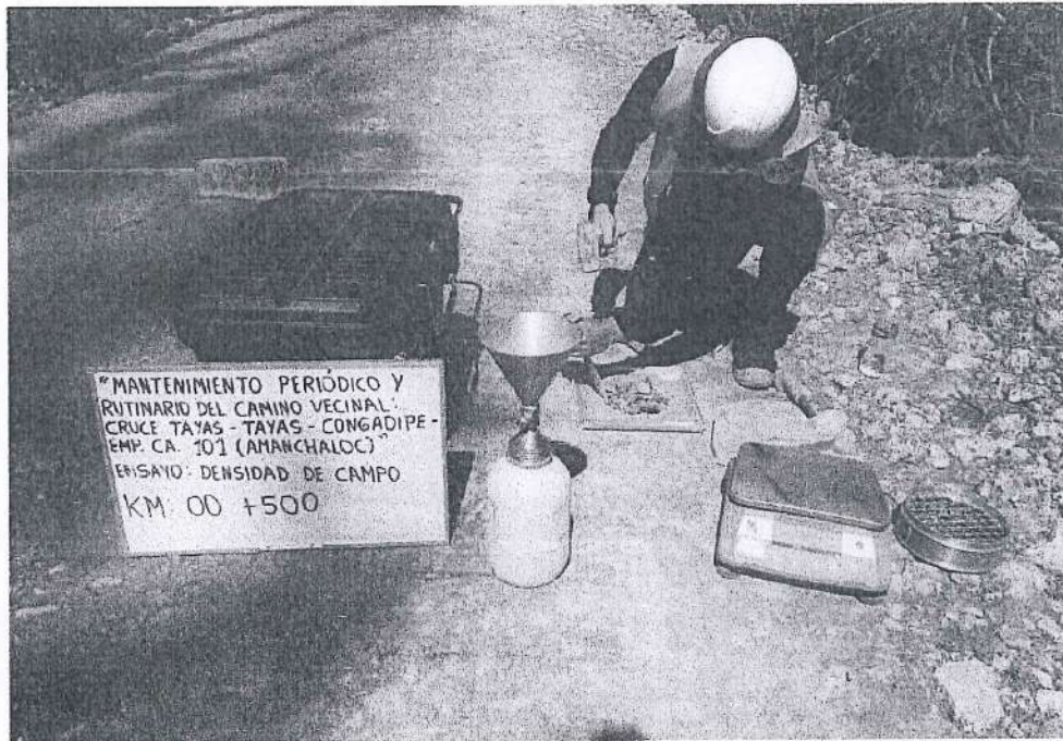
FIGURA 3. Ensayo de Densidad de Suelo en Campo en la progresiva Km 00+500
