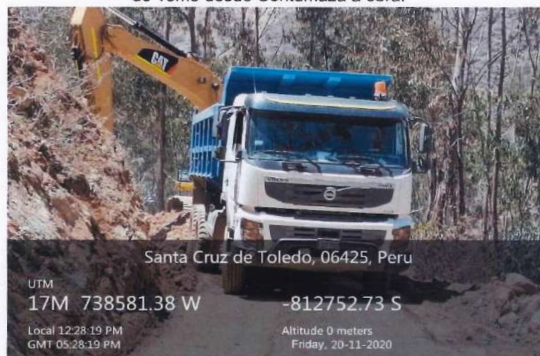
Fotografía 38. Carguío de material granular para afirmado.
