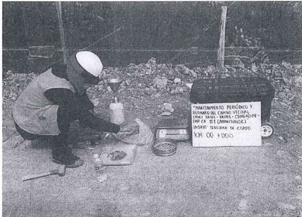
FIGURA 1. Ensayo de Densidad de Suelo en Campo en la progresiva Km 00+000
