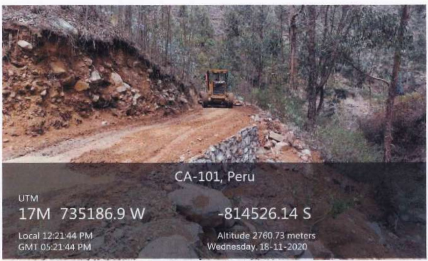
Fotografía 35. Motoniveladora realizando trabajos de escarificado de la vía.
