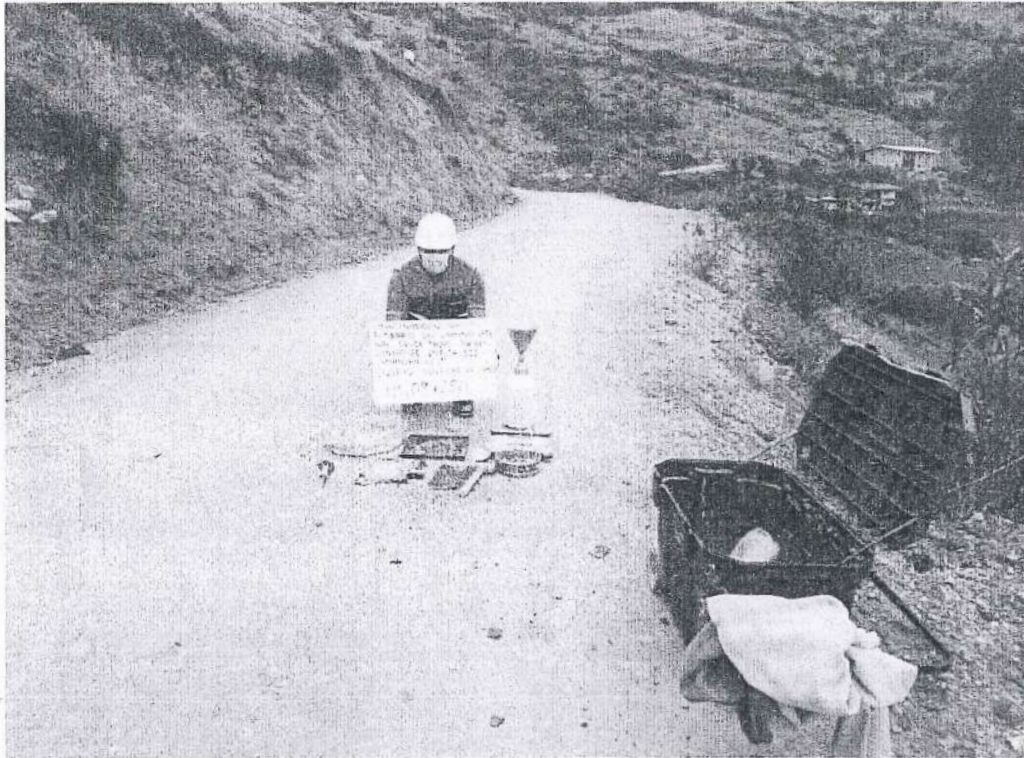
Fotografía N° 7. Ensayo de Densidad de Campo en la progresiva Km. 9+250
