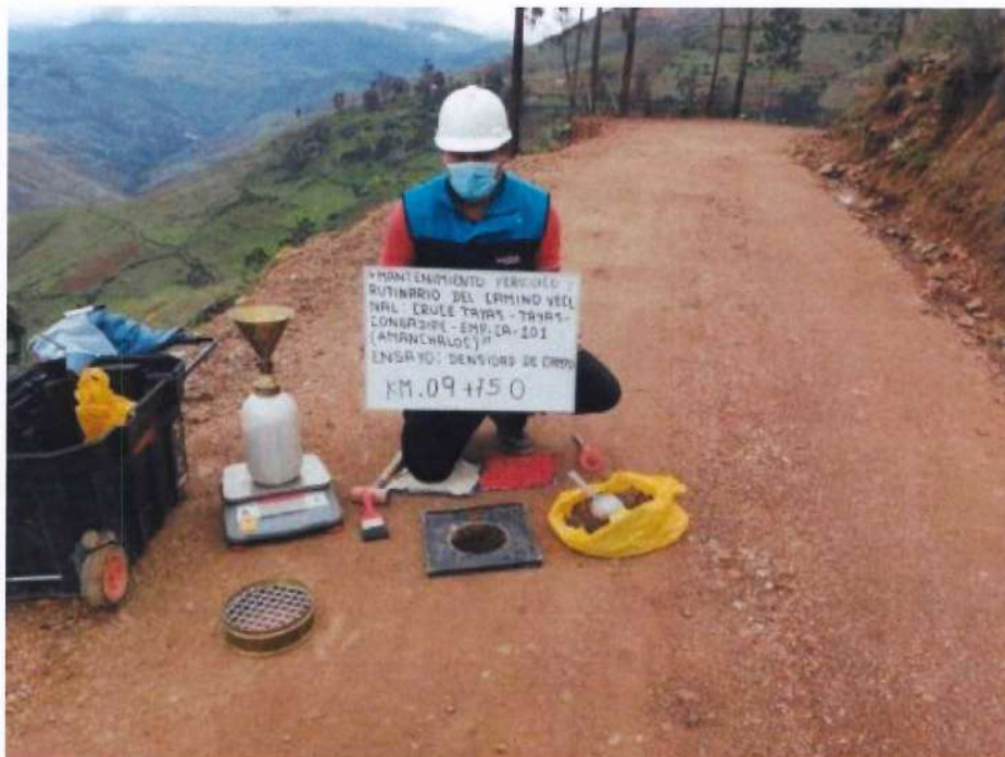
Fotografía 114. Densidad de campo el km 09+750.
