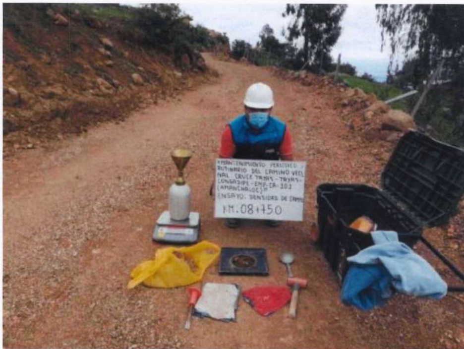
Fotografía 110. Densidad de campo el km 08+750.
