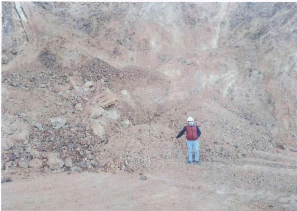
Fotografía 136. Verificación por parte del inspector que el material de cantera sea seleccionado.
