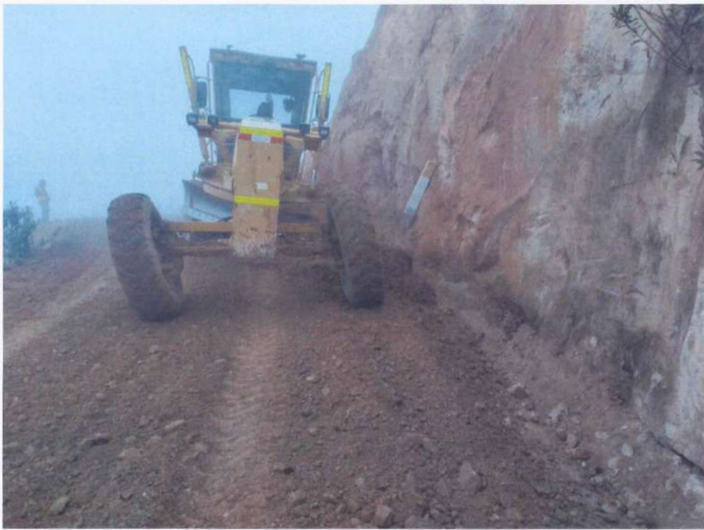
Fotografía 77. Motoniveladora realizando trabajos de Reconformación de cunetas.
