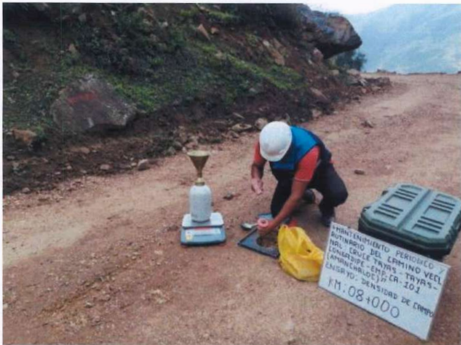
Fotografía 108. Densidad de campo el km 08+000.
