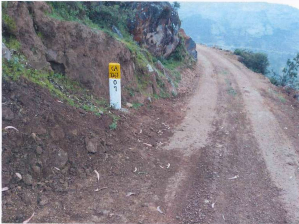
Fotografía 91. Instalación de hito kilométrico en KM 07+000.
