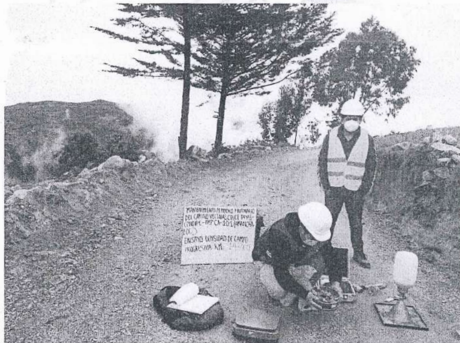
FOTOGRAFÍA N°14. Ensayo N°14 de Densidad de Suelo en Campo (Método del cono de arena) en la progresiva Km 14+000.
