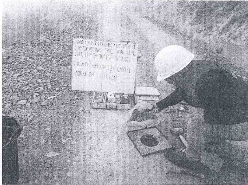
FOTOGRAFÍA N°1. Ensayo N°01 de Densidad de Suelo en Campo (Método del cono de arena) en la progresiva Km 10+750.
