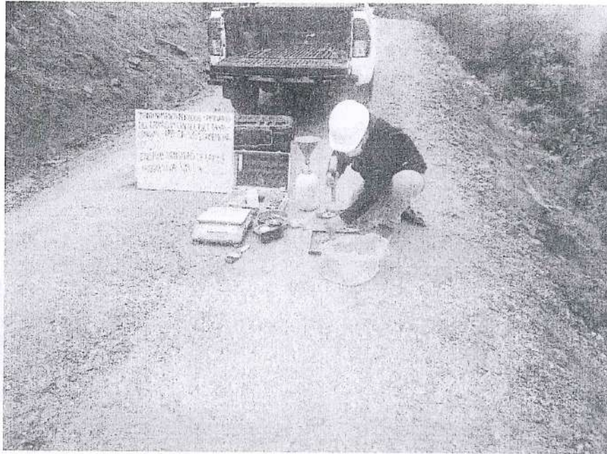
FOTOGRAFÍA N°7. Ensayo N°07 de Densidad de Suelo en Campo (Método del cono de arena) en la progresiva Km 12+250.
