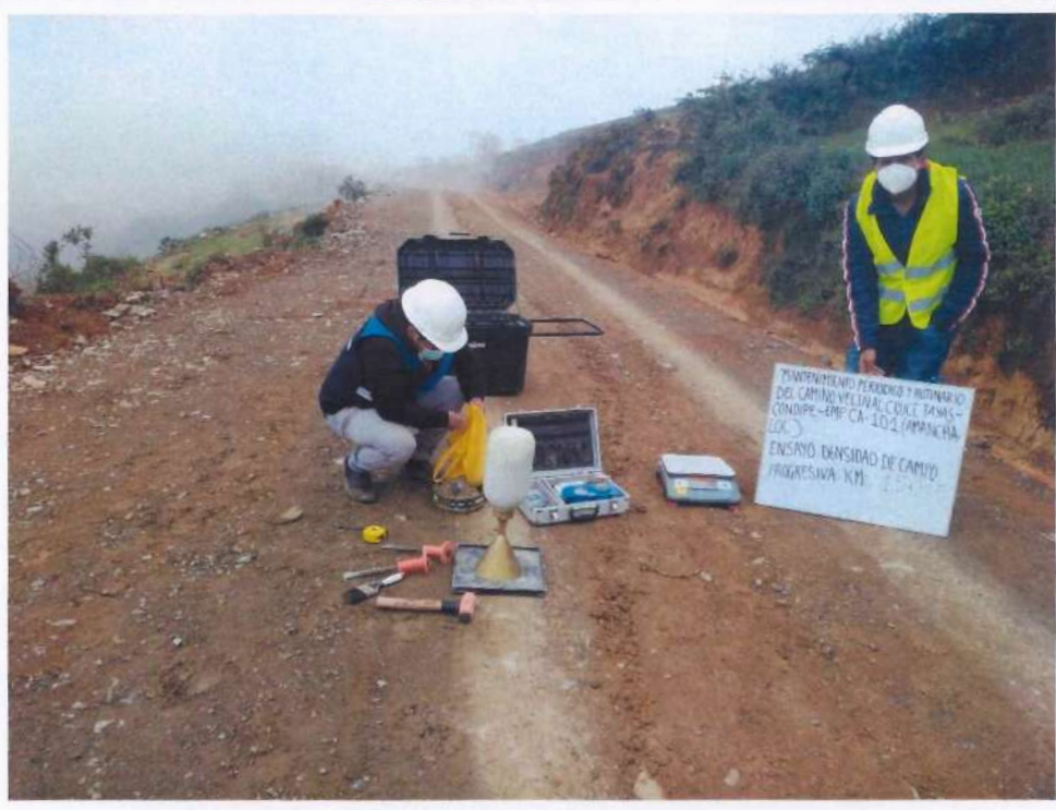
Fotografía 131. Densidad de campo el km 15+240.
