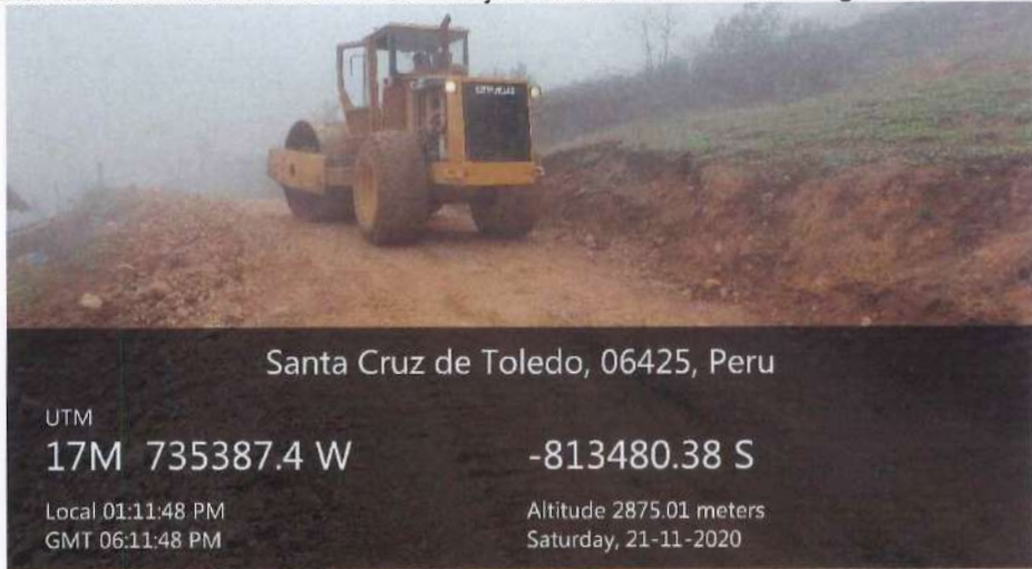
Fotografía 42. Rodillo realizando trabajos de compactación en la vía.
