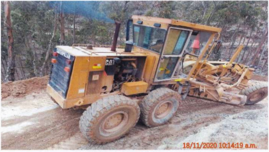
Fotografía 34. Motoniveladora realizando trabajos de escarificado de la vía.
