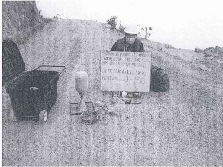
FOTOGRAFÍA N°5. Ensayo N°05 de Densidad de Suelo en Campo (Método del cono de arena) en la progresiva Km 11+750.
