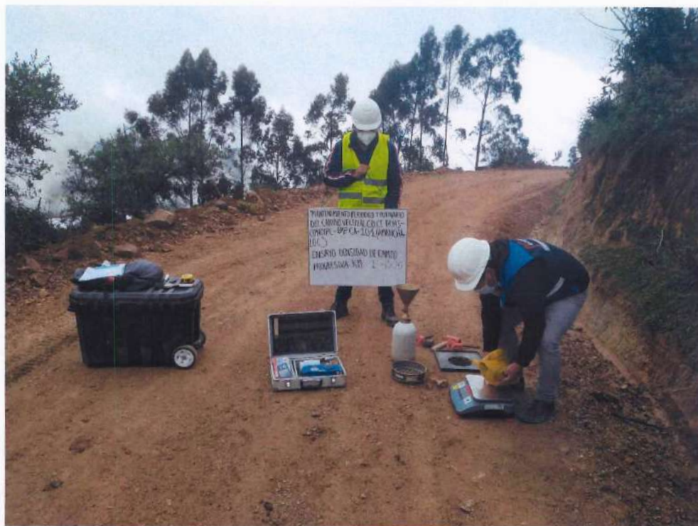
Fotografía 128. Densidad de campo el km 14+500.
