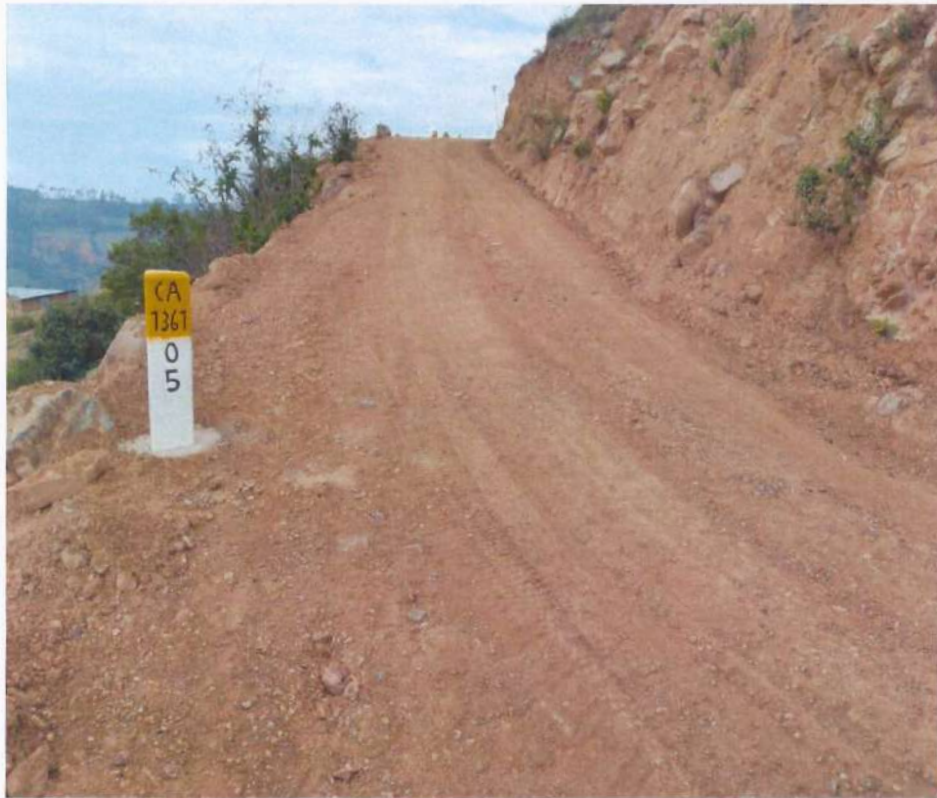
Fotografía 89. Instalación de hito kilométrico en KM 05+000.
