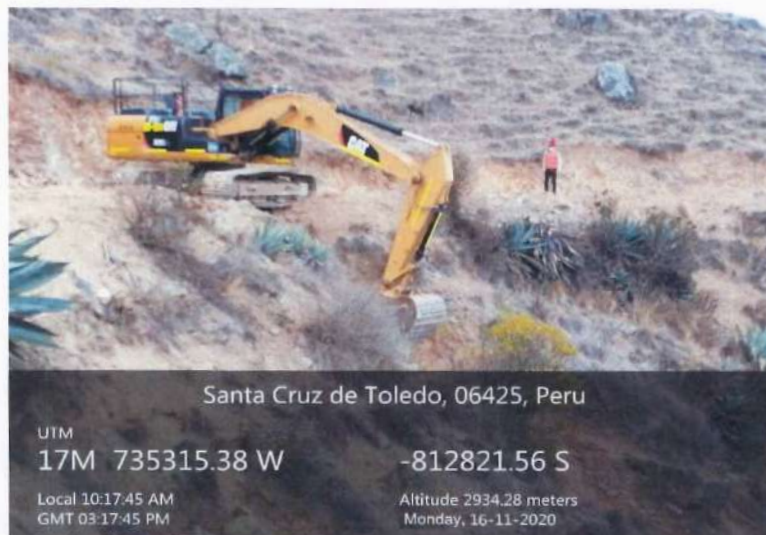
Fotografía 29. Movilización de la excavadora de orugas 320D 2L, hasta puntos críticos identificados con el fin de ampliar la vía para dar acceso a vehículos pesados
