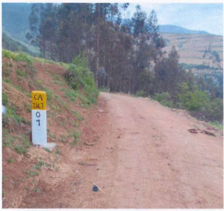
Fotografía 86. Instalación de hito kilométrico en KM 01+000.
