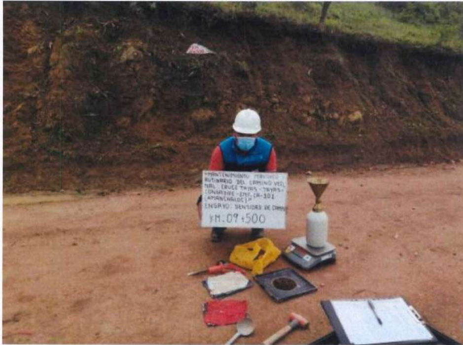
Fotografía 113. Densidad de campo el km 09+500.
