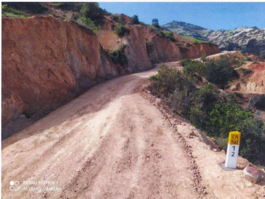
Fotografía 96. Instalación de hito kilométrico en KM 12+000.
