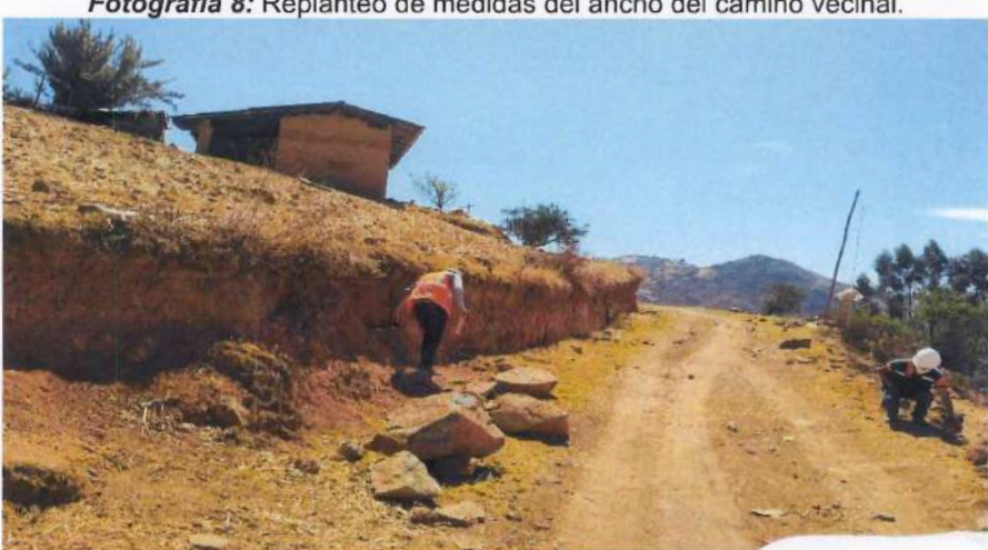
Fotografía 9: Replanteo de medidas del ancho del camino vecinal.
