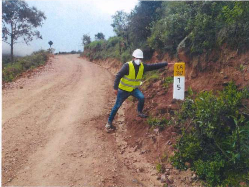
Fotografía 99. Instalación de hito kilométrico en KM 15+000.
