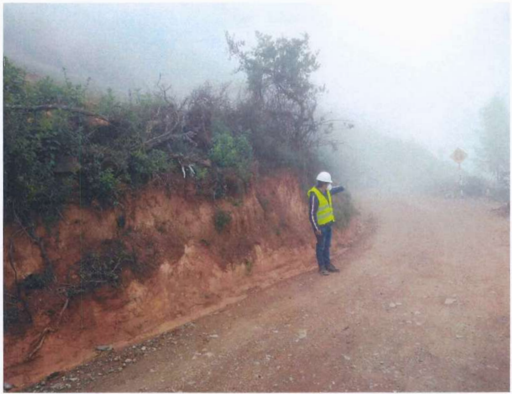
Fotografía 106. Instalación de Señales Preventivas
