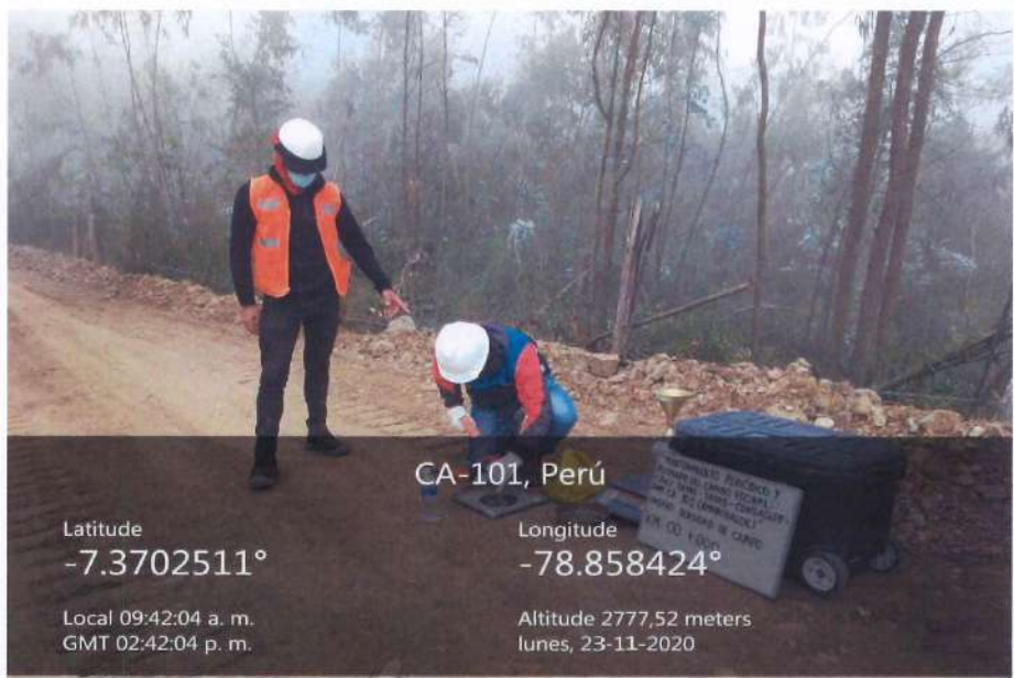
Fotografía 54. Densidad de campo el km 00+000.
