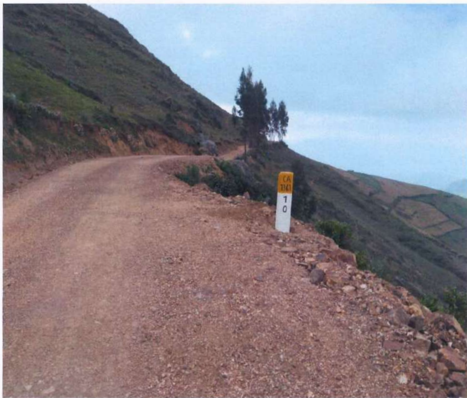
Fotografía 94. Instalación de hito kilométrico en KM 10+000.
