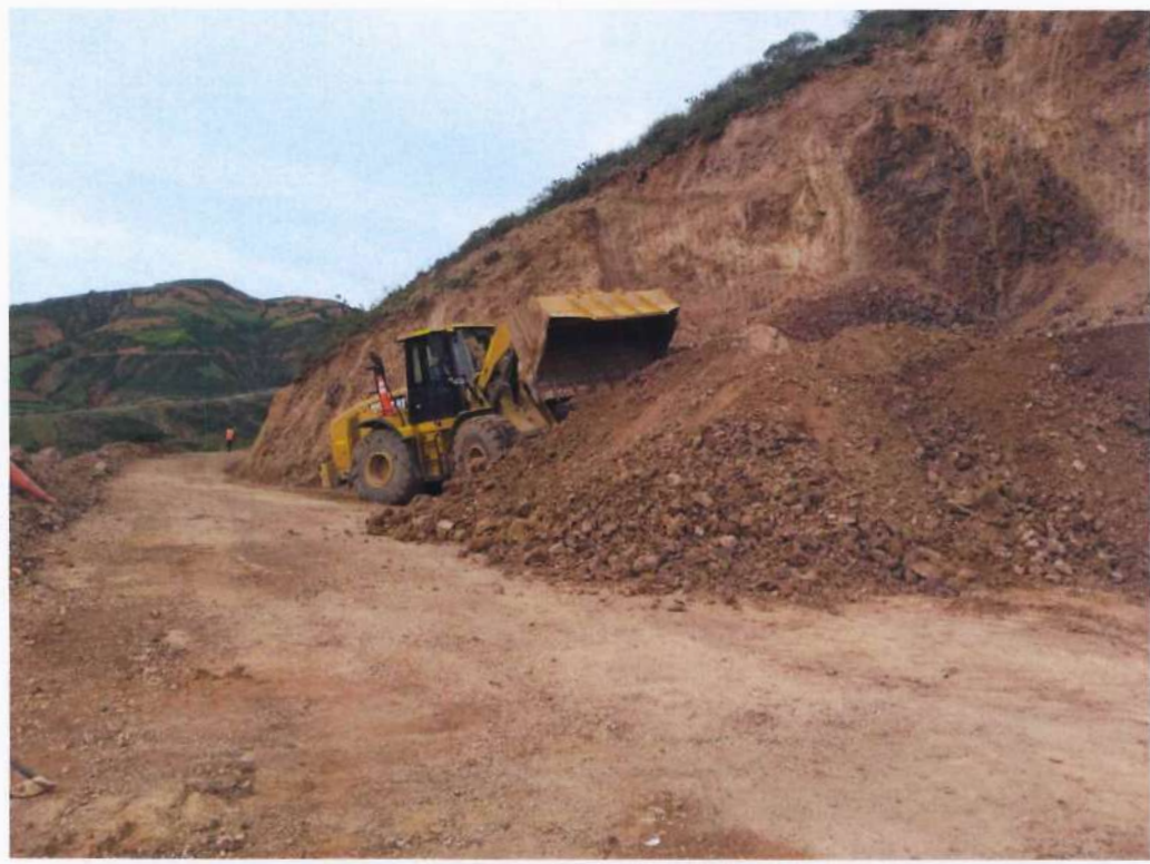
Fotografía 80. Acumulación de material granular de cantera seleccionado.
