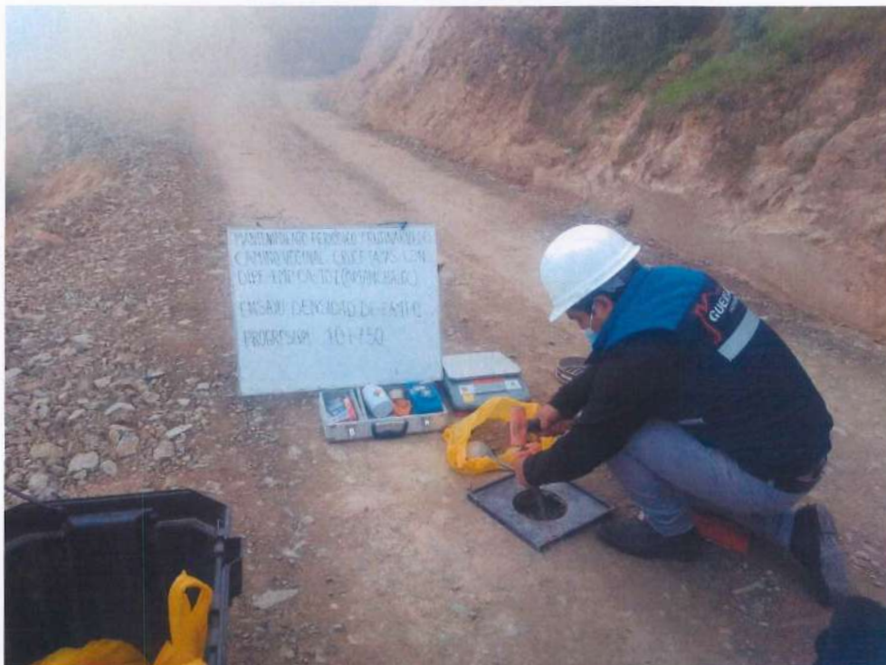
Fotografía 118. Densidad de campo el km 10+750.
