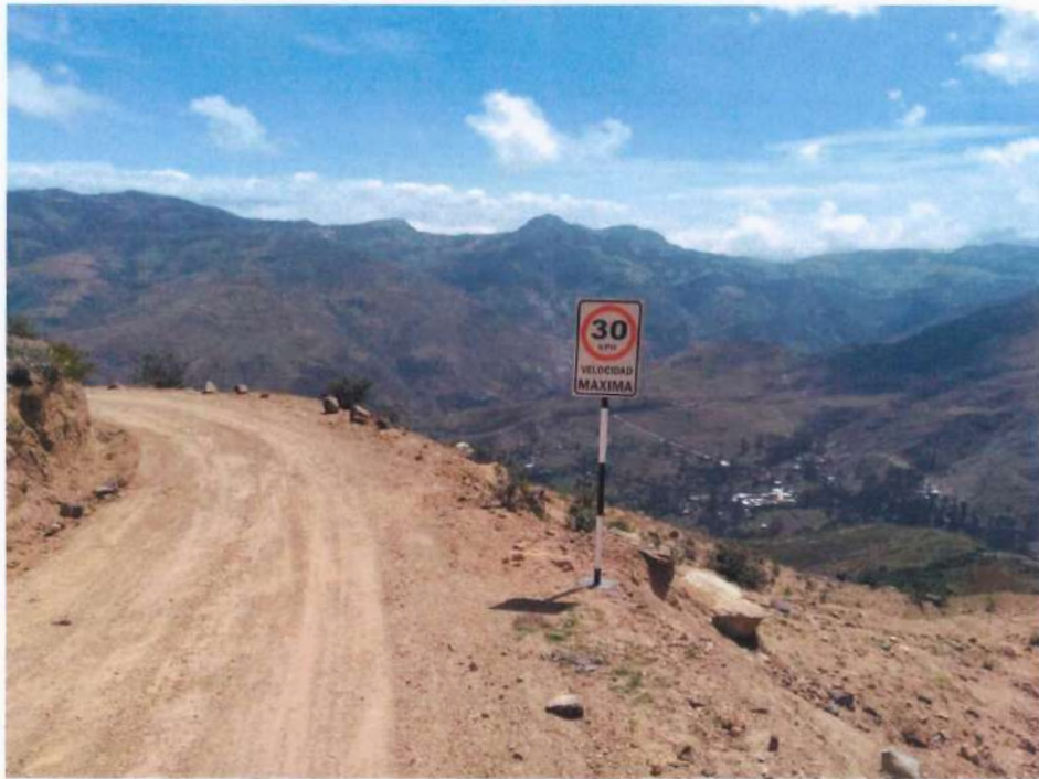
Fotografía 102. Instalación de Señales Reglamentarias.
