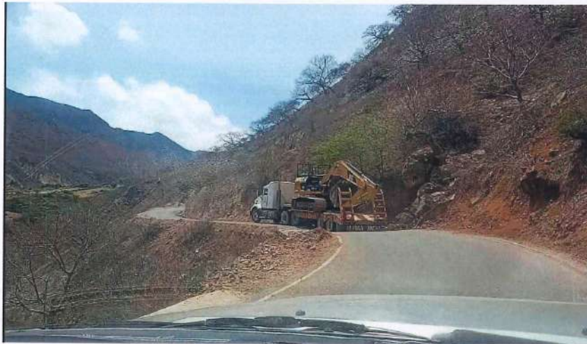
Fotografía 1: Movilización de excavadora 320 2L CAT desde Cajamarca a la obra.
