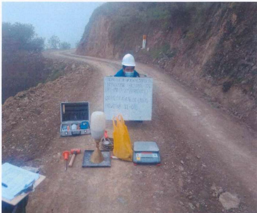
Fotografía 120. Densidad de campo el km 12+000.
