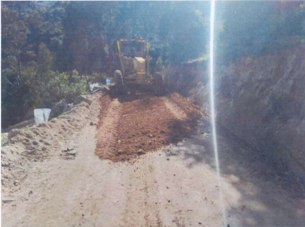
Fotografía 75. Motoniveladora realizando trabajos de extendido de material granular en la vía.
