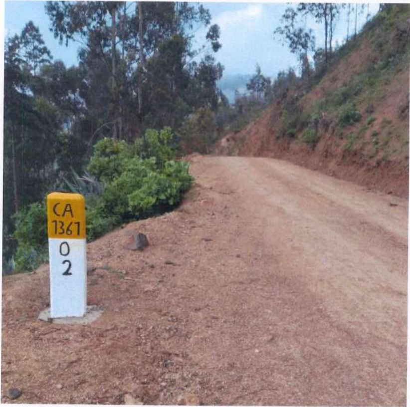
Fotografía 87. Instalación de hito kilométrico en KM 02+000.
