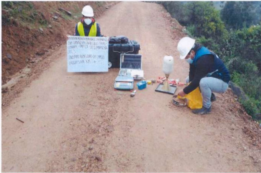
Fotografía 121. Densidad de campo el km 12+250.
