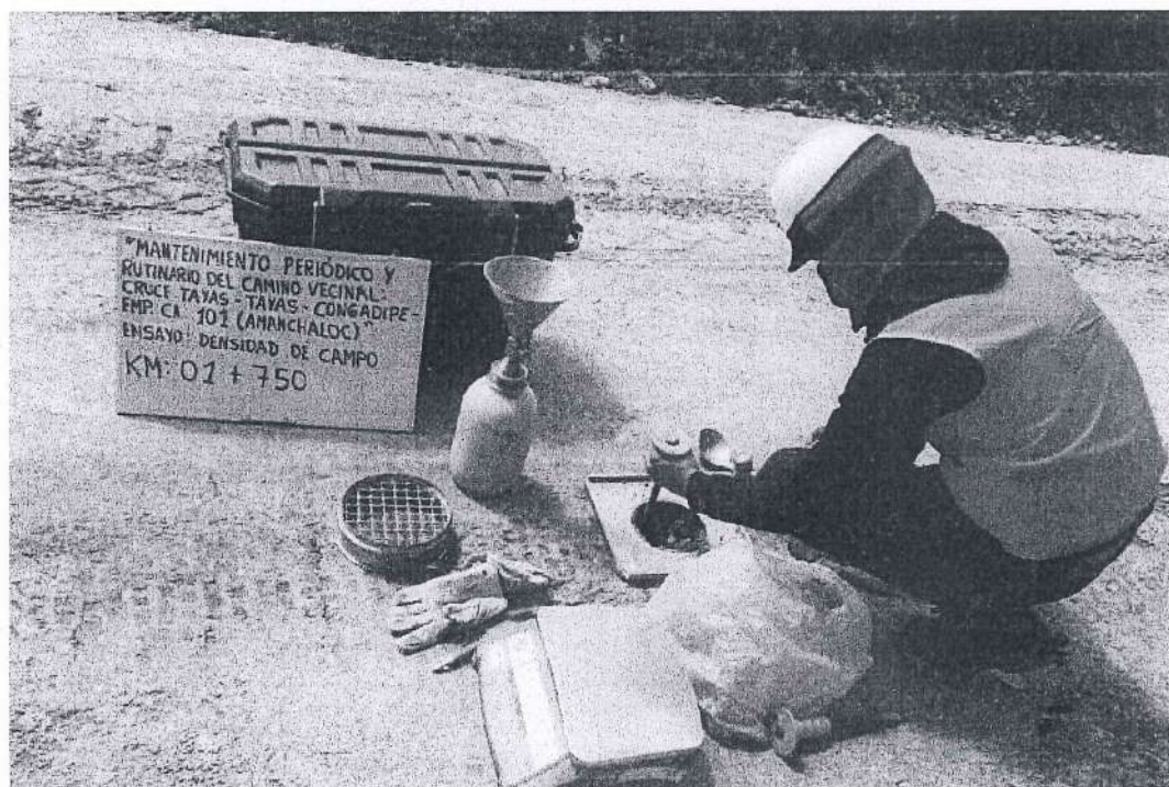
FIGURA 8. Ensayo de Densidad de Suelo en Campo en la progresiva Km 01+750
