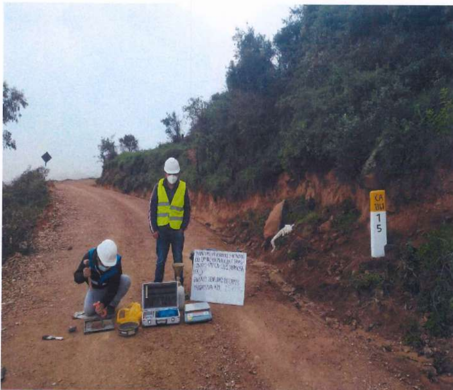
Fotografía 130. Densidad de campo el km 15+000.
