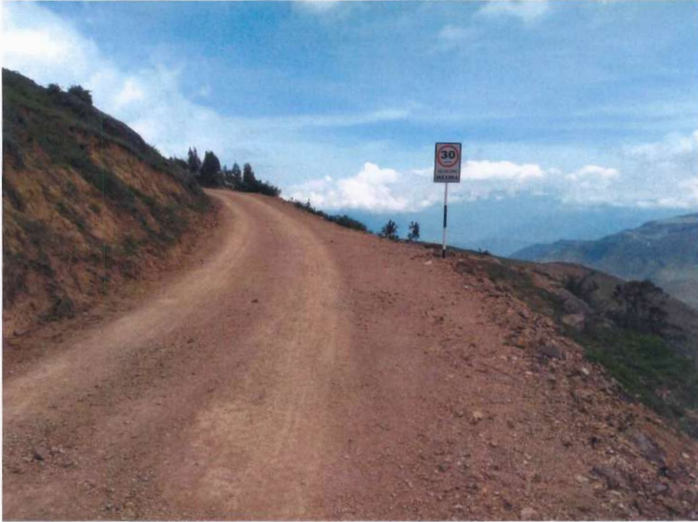
Fotografía 103. Instalación de Señales Reglamentarias.
