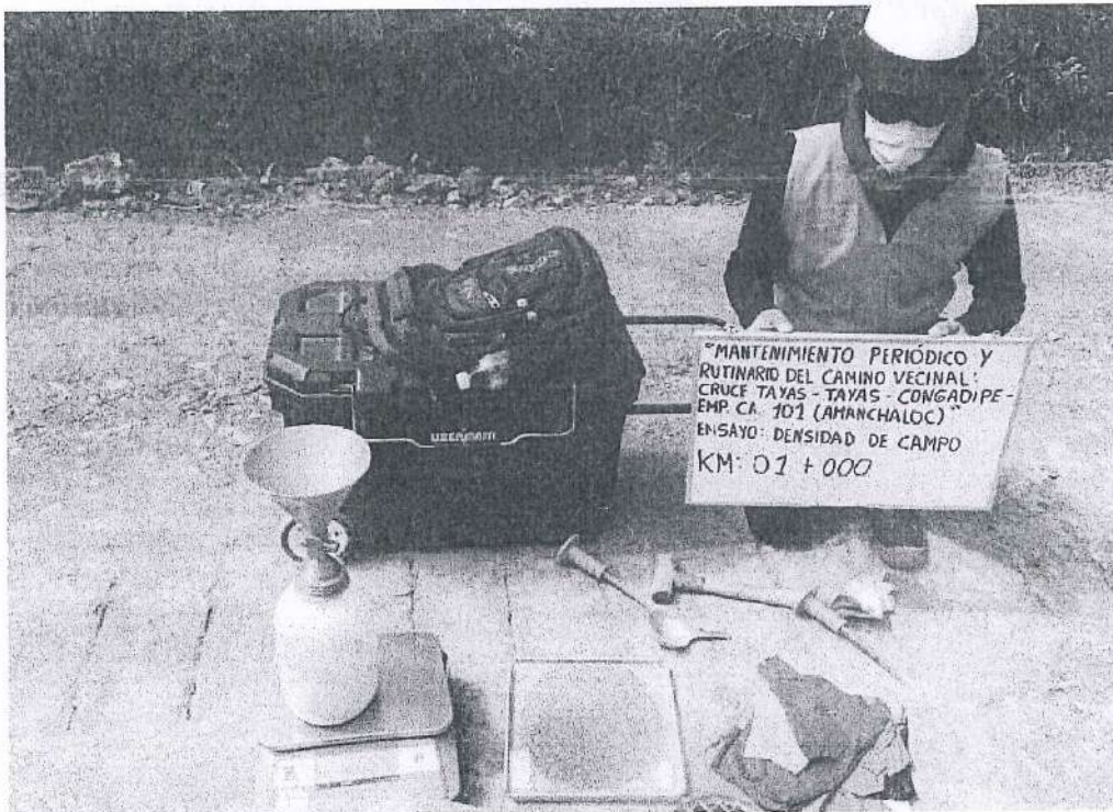
FIGURA 5. Ensayo de Densidad de Suelo en Campo en la progresiva Km 01+000
