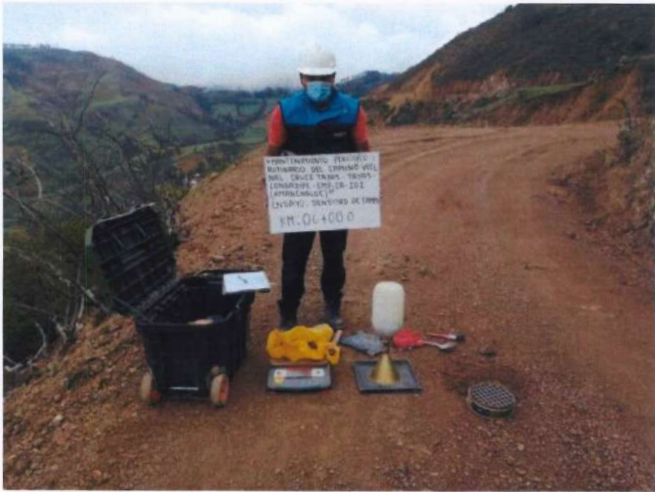
Fotografía 107. Densidad de campo el km 06+000.
