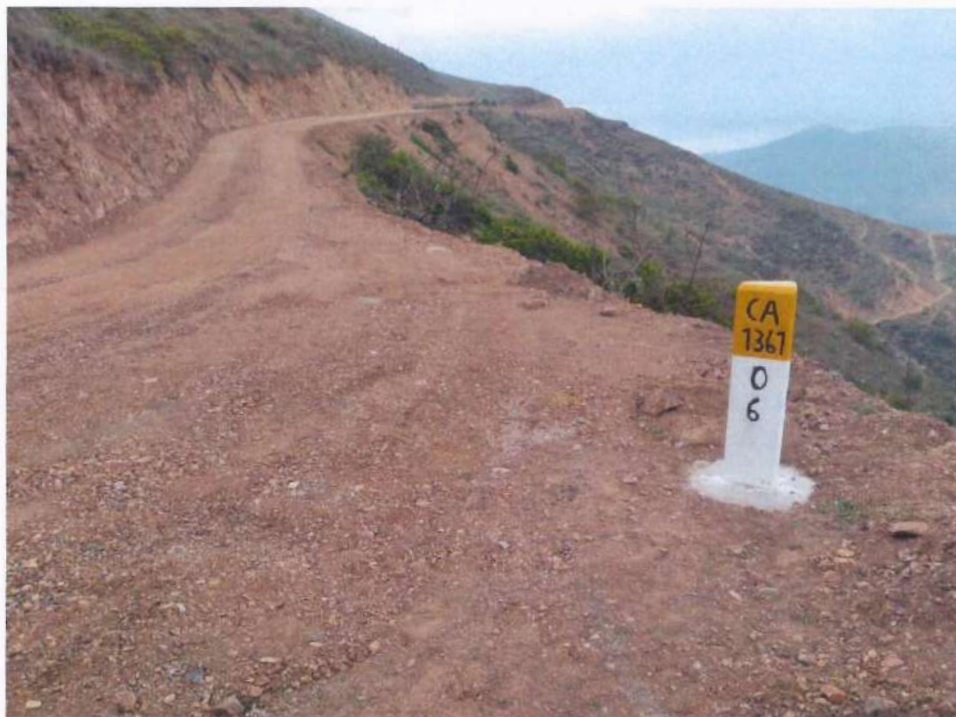
Fotografía 90. Instalación de hito kilométrico en KM 06+000.
