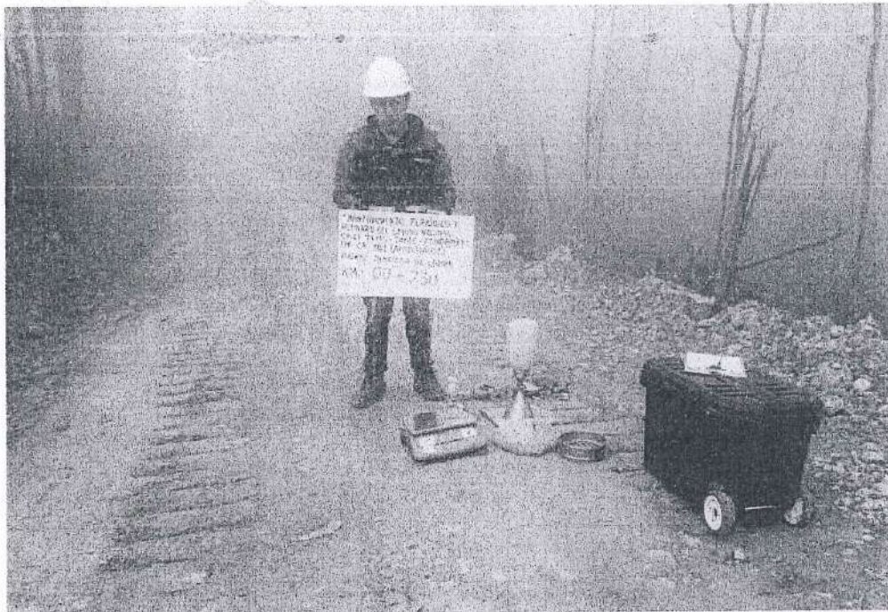
FIGURA 4. Ensayo de Densidad de Suelo en Campo en la progresiva Km 00+750
