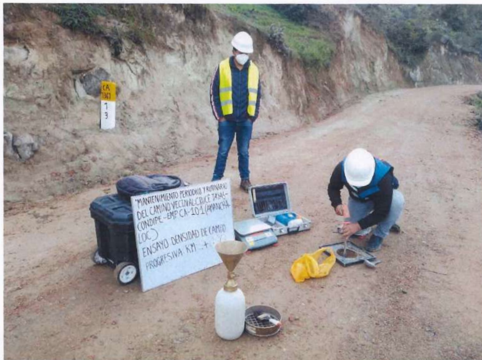
Fotografía 124. Densidad de campo el km 13+000.
