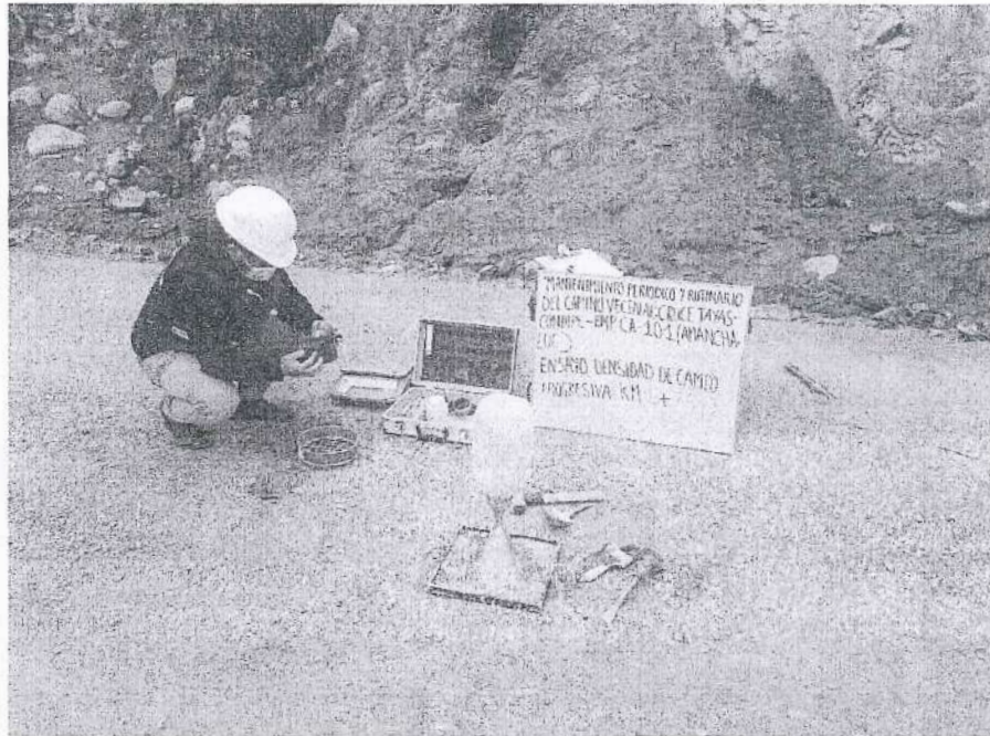
FOTOGRAFÍA N°13. Ensayo N°13 de Densidad de Suelo en Campo (Método del cono de arena) en la progresiva Km 13+750.
