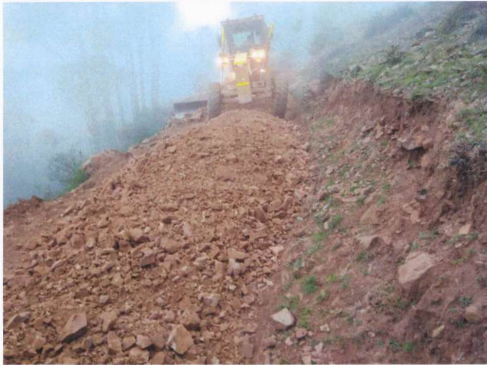
Fotografía 65. Motoniveladora realizando trabajos de extendido de material granular en la vía.
