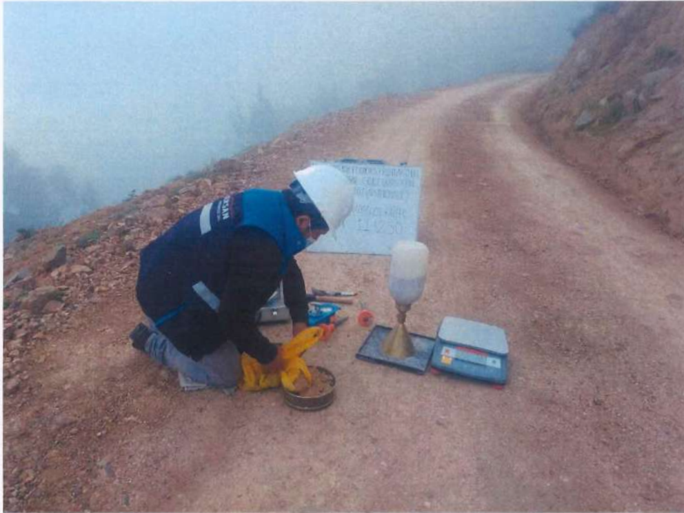
Fotografía 119. Densidad de campo el km 11+250.
