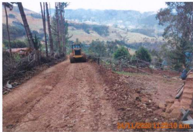
Fotografía 46. Rodillo realizando trabajos de compactación en la vía.
