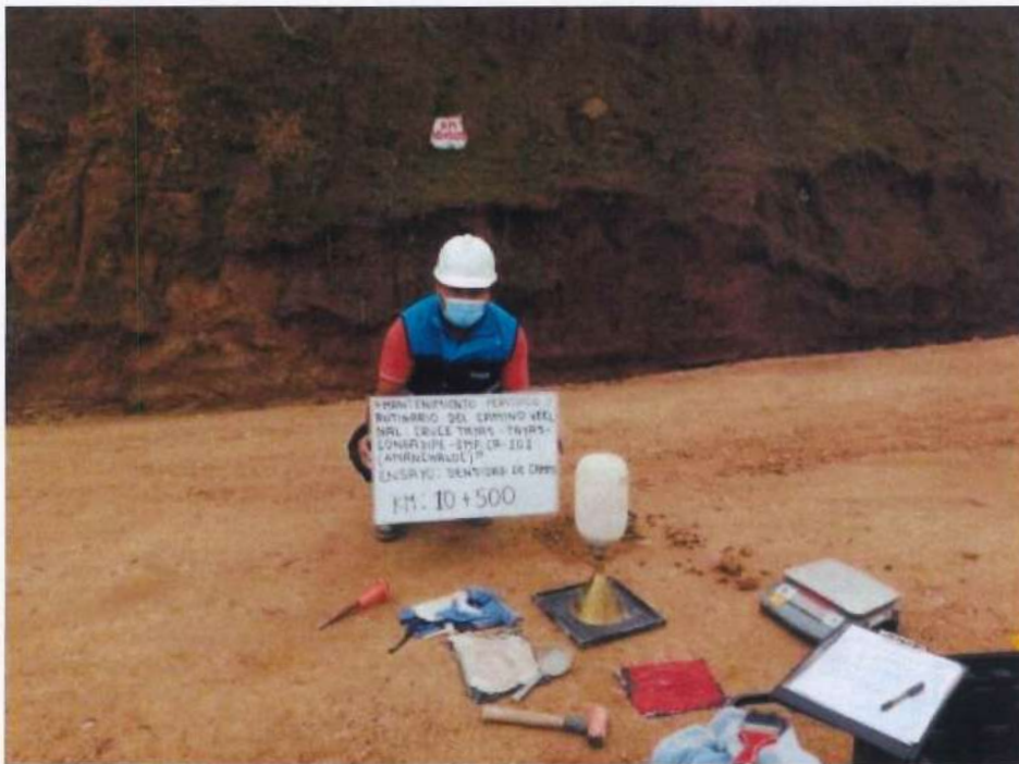
Fotografía 117. Densidad de campo el km 10+500.
