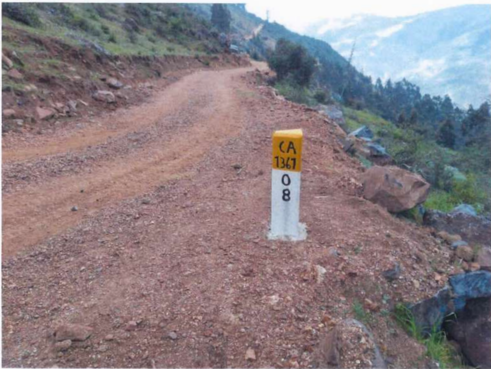
Fotografía 92. Instalación de hito kilométrico en KM 08+000.
