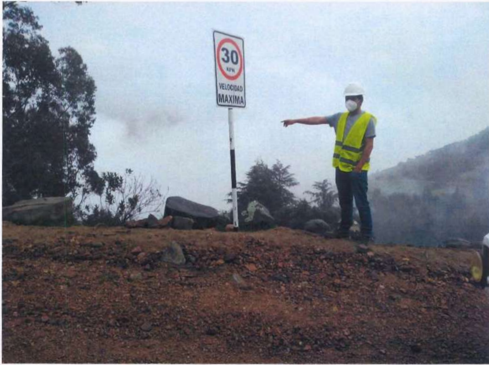
Fotografía 101. Instalación de Señales Reglamentarias.
