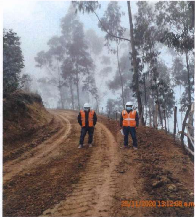
Fotografía 53. El inspector verificando los trabajos que se viene realizando.
