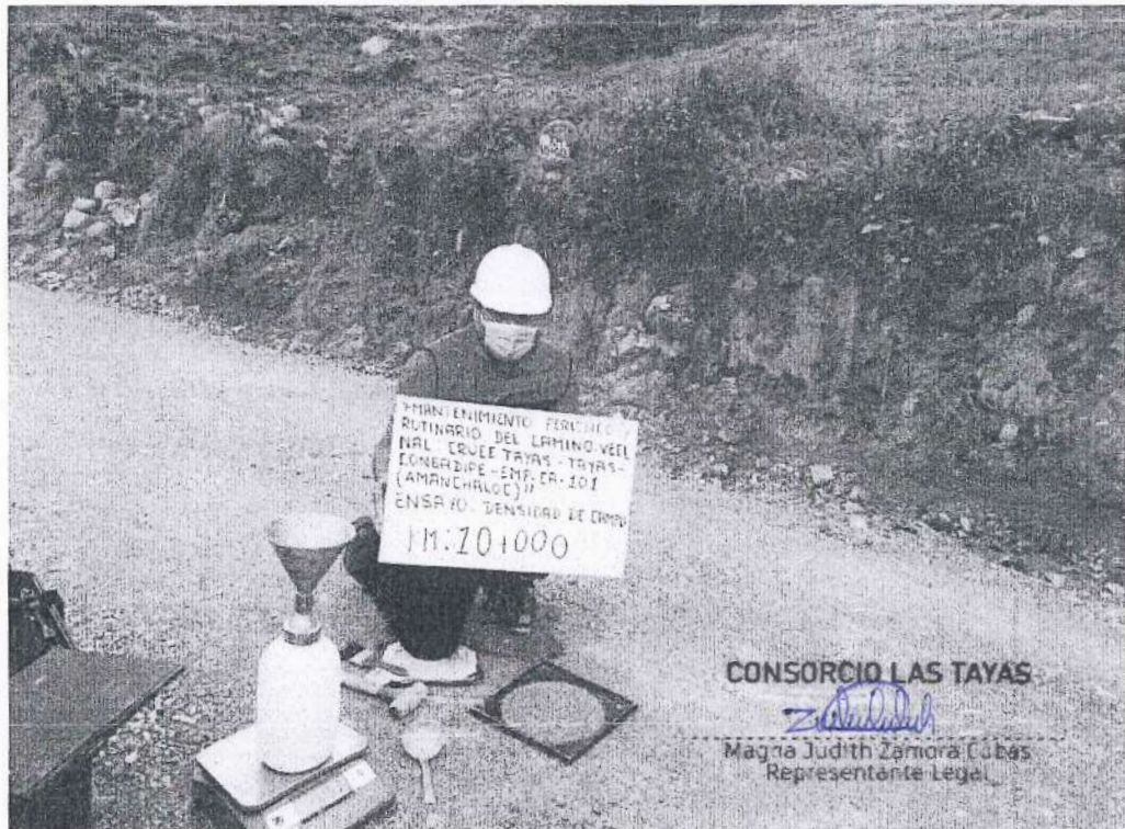
Fotografía N° 10. Ensayo de Densidad de Campo en la progresiva Km. 10+000
