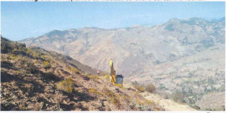
Fotografía 11: Extracción de material en cantera del señor Santos Medina Ubicada Progresiva KM 5+354.72 en las coordenadas: 735380.92E 9186457.01N.
