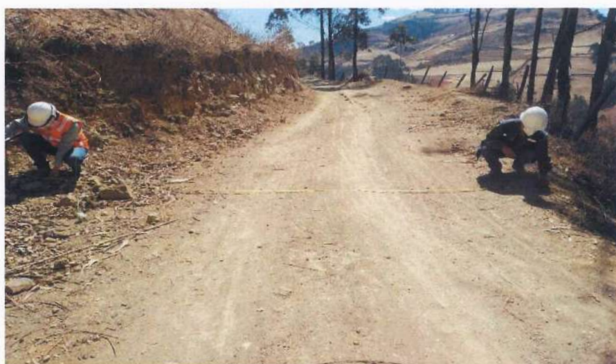
Fotografía 6: Replanteo de medidas del ancho del camino vecinal.
