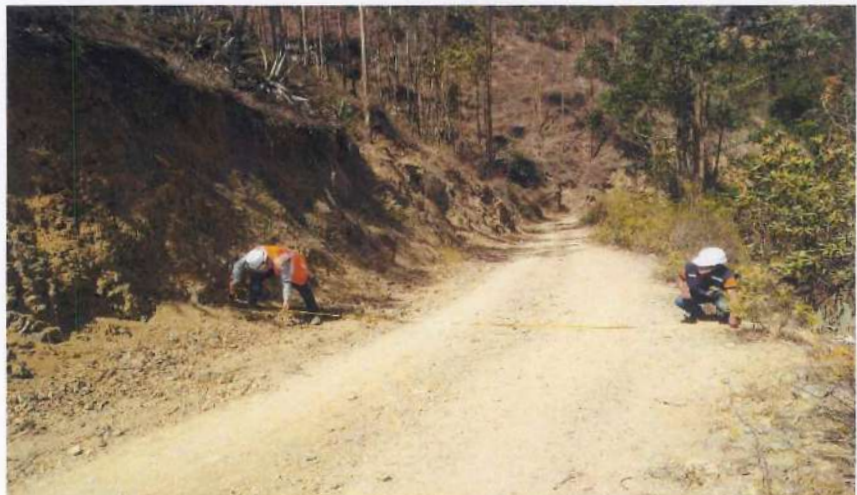
Fotografía 7: Replanteo de medidas del ancho del camino vecinal.
