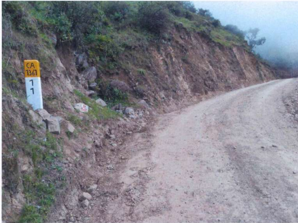
Fotografía 95. Instalación de hito kilométrico en KM 11+000.
