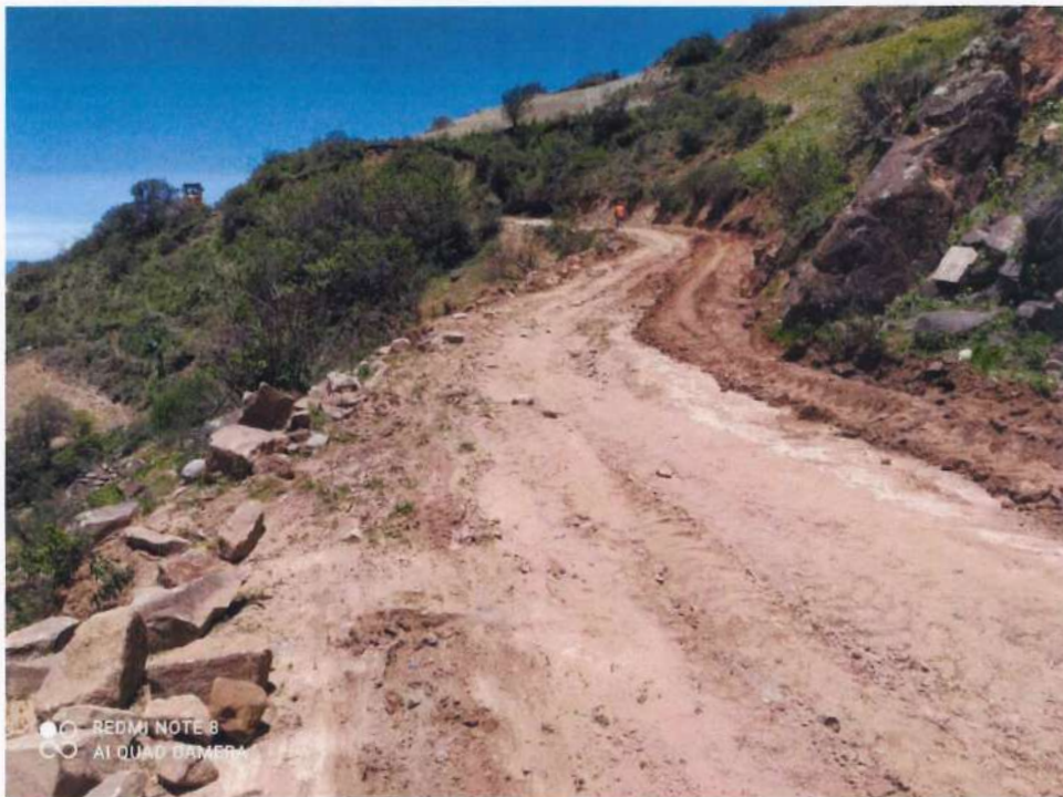
Fotografía 76. Motoniveladora realizando trabajos de Reconfiguración de cunetas.
