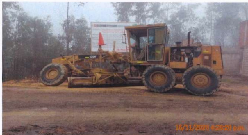
Fotografía 32. Trabajos de escarificado desde la progresiva Km 00+000 hasta la progresiva Km 00+500.
