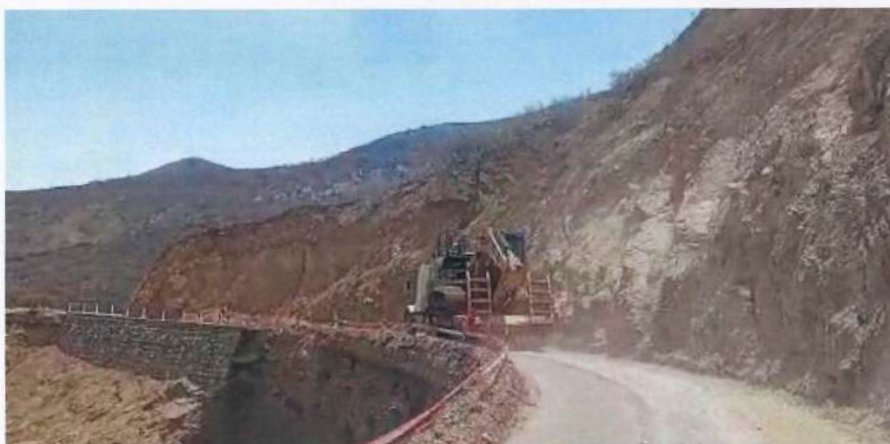
Fotografía 4: Movilización de excavadora 320 2L CAT desde Cajamarca a la obra.
