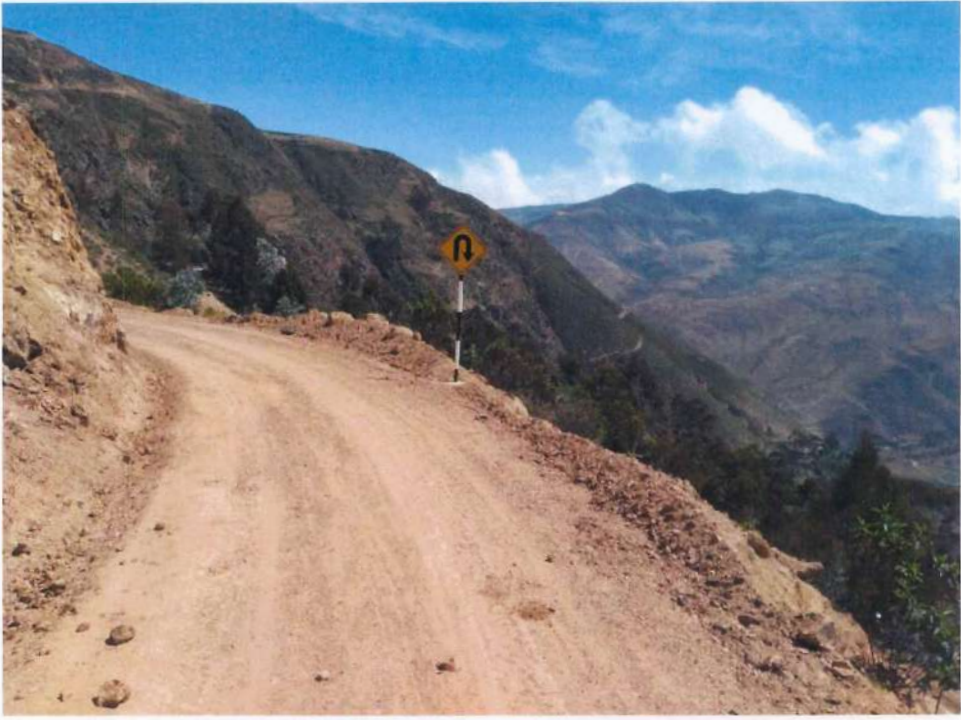
Fotografía 105. Instalación de Señales Preventivas
