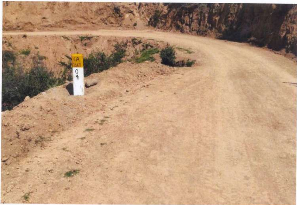
Fotografía 88. Instalación de hito kilométrico en KM 04+000.
