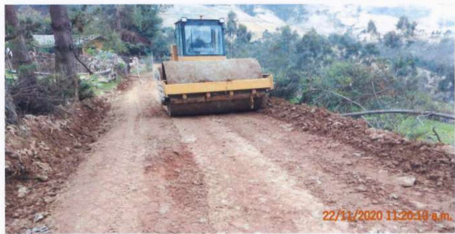
Fotografía 43. Rodillo realizando trabajos de compactación en la vía.
