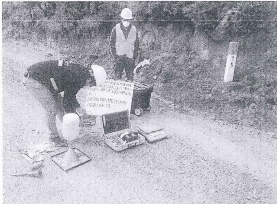
FOTOGRAFÍA N°18. Ensayo N°18 de Densidad de Suelo en Campo (Método del cono de arena) en la progresiva Km 15+000.
