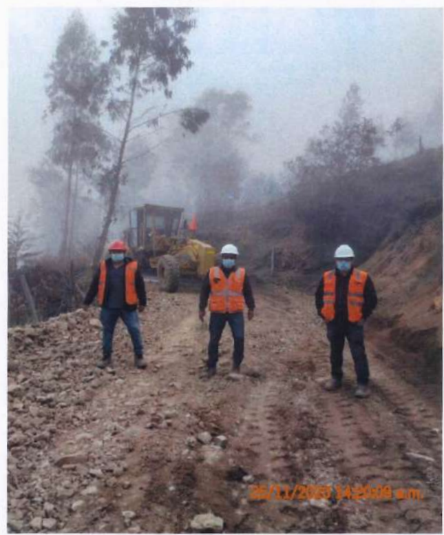
Fotografía 52. El inspector verificando los trabajos que se viene realizando.
