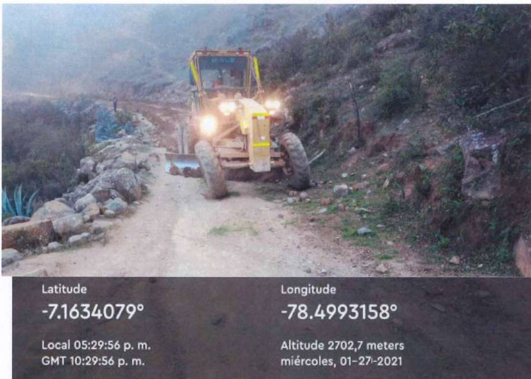
Fotografía 62. Motoniveladora realizando trabajos de escarificado de la vía.
