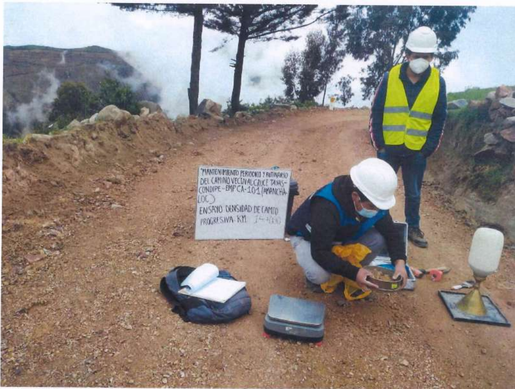
Fotografía 126. Densidad de campo el km 14+000.
