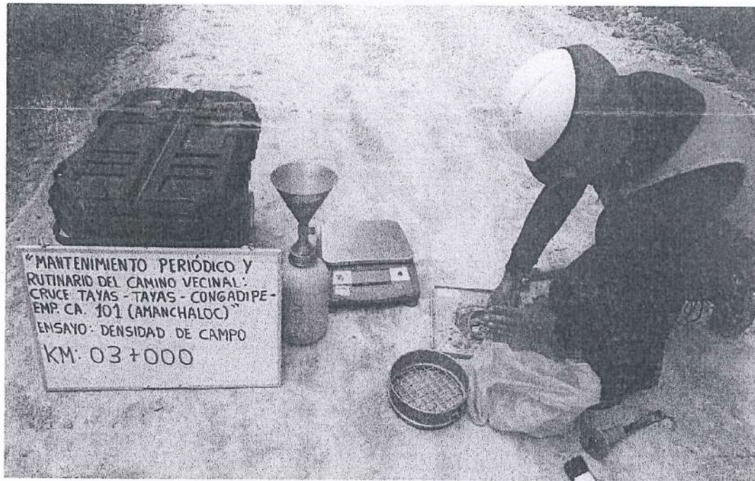
FIGURA 13. Ensayo de Densidad de Suelo en Campo en la progresiva Km 03+000
