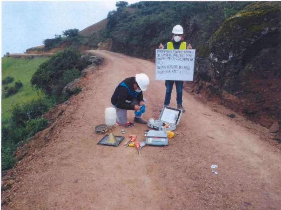
Fotografía 122. Densidad de campo el km 12+500.
