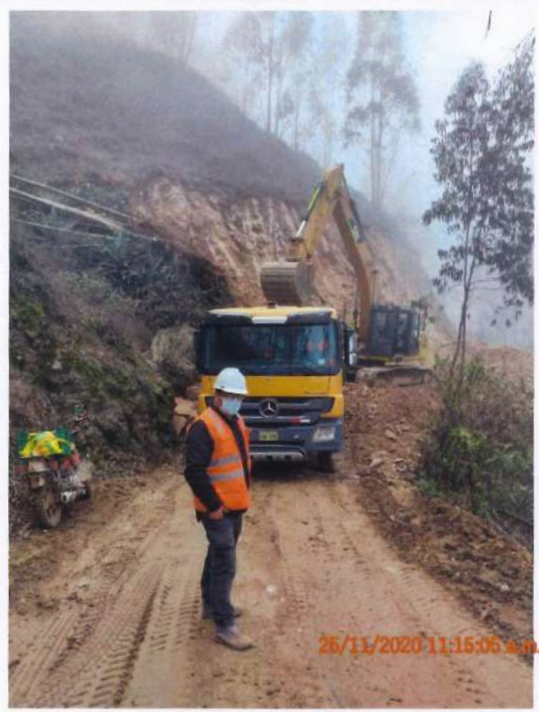
Fotografía 51. El inspector verificando los trabajos que se viene realizando.
