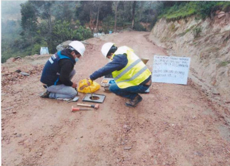
Fotografía 123. Densidad de campo el km 11+750.
