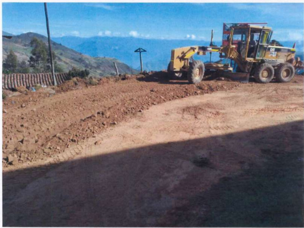
Fotografía 79. Motoniveladora realizando trabajos de extendido de material granular en la vía.
