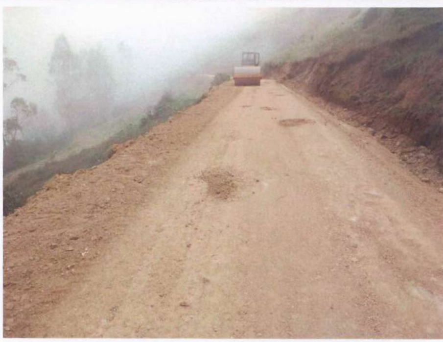
Fotografía 69. Rodillo realizando trabajos de compactación en la vía.
