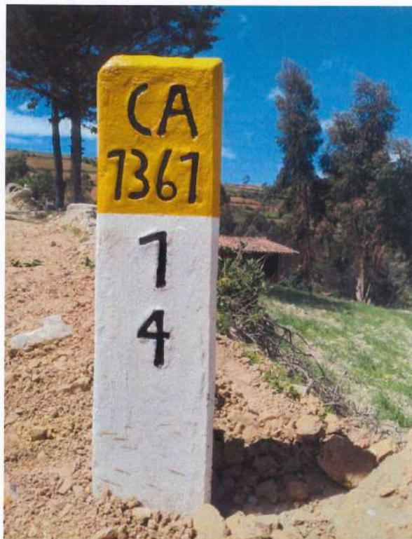
Fotografía 98. Instalación de hito kilométrico en KM 14+000.
