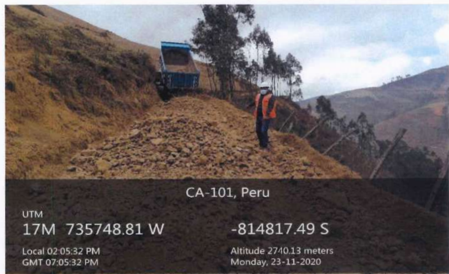
Fotografía 44. Volquetes realizando trabajos de carguío de material en la vía
