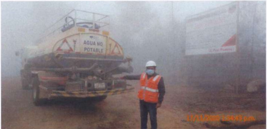
Fotografía 33. Movilización de una cisterna desde el distrito de Guzmango a obra.
