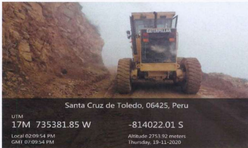
Fotografía 36. Motoniveladora realizando trabajos de escarificado de la vía.
