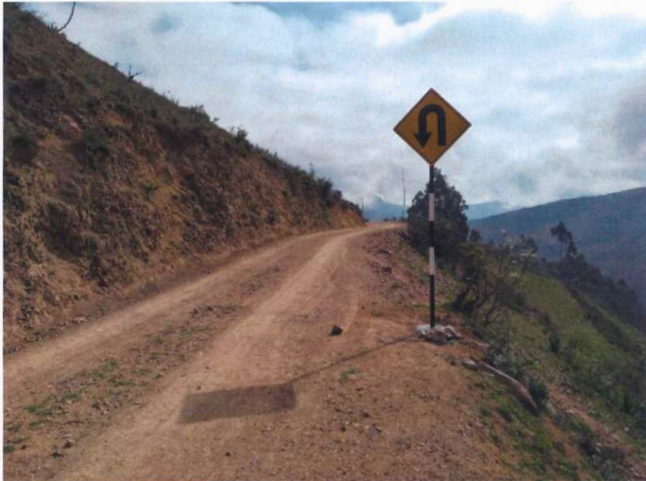
Fotografía 104. Instalación de Señales Preventivas
