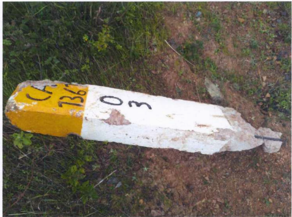
Fotografía 132. Verificación de los daños ocasionados al hito kilométrico 03 por personas ajenas a la obra .
