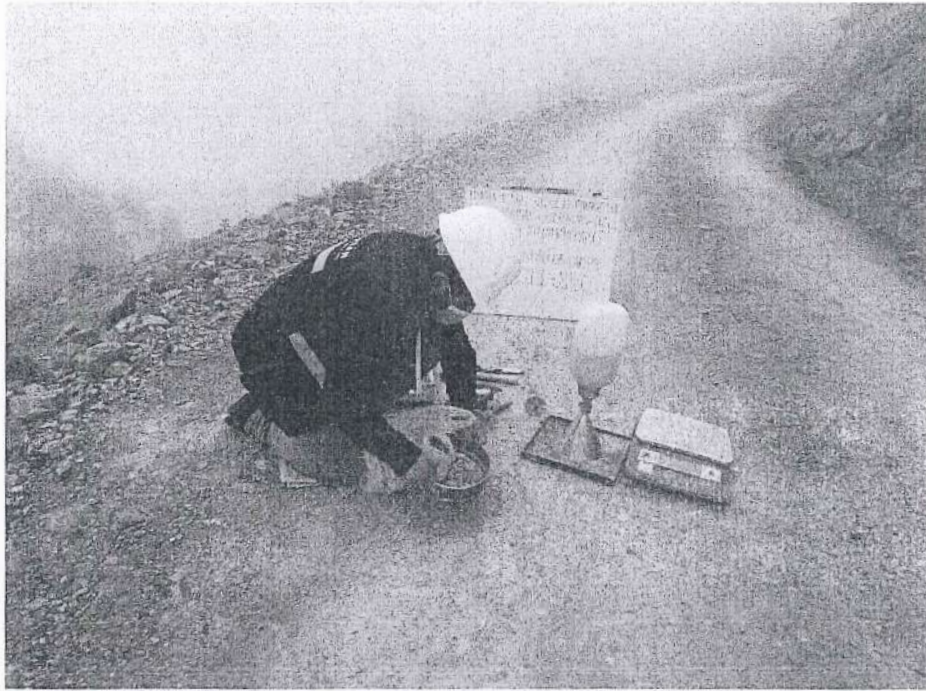
FOTOGRAFÍA N°3. Ensayo N°03 de Densidad de Suelo en Campo (Método del cono de arena) en la progresiva Km 11+250.
