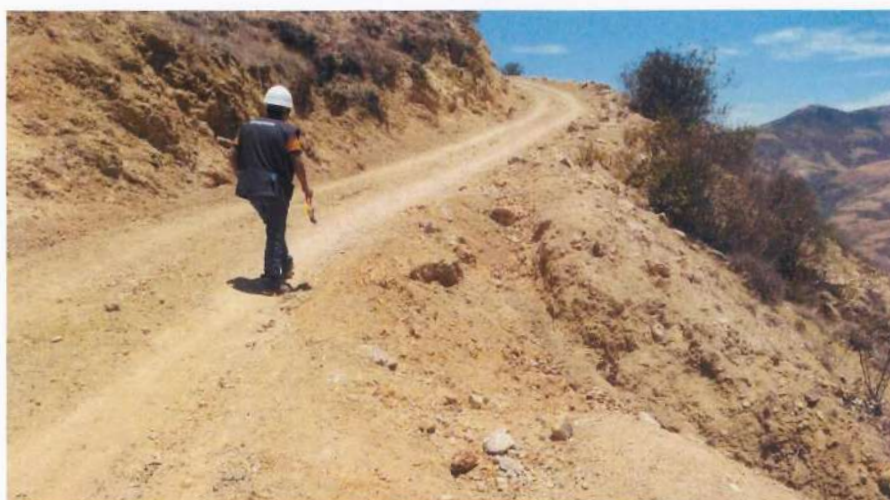
Fotografía 5: Foto panorámica de la realización del trazo y replanteo del camino vecinal.
