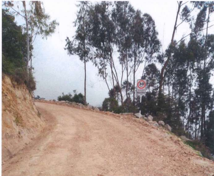
Fotografía 100. Instalación de Señales Reglamentarias.
