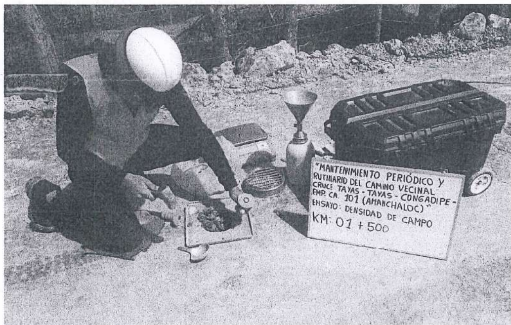
FIGURA 7. Ensayo de Densidad de Suelo en Campo en la progresiva Km 01+500
