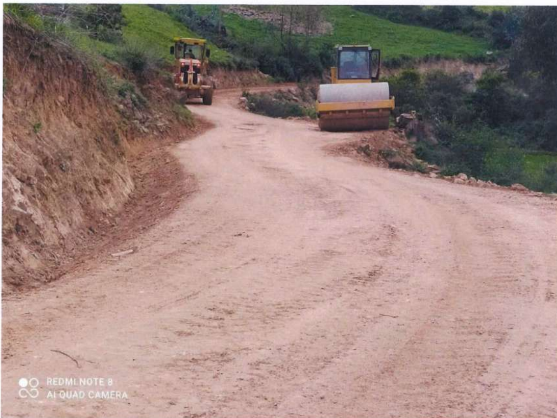
Fotografía 74. Rodillo realizando trabajos de compactación en la vía.
