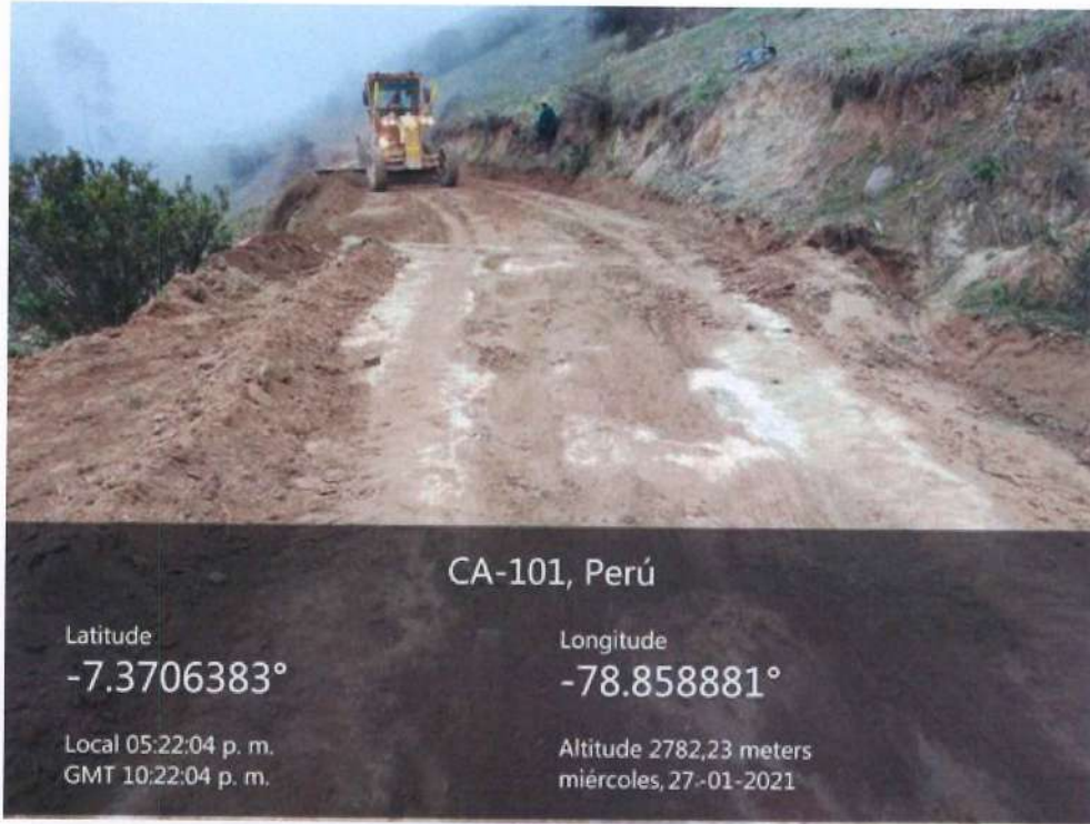
Fotografía 63. Motoniveladora realizando trabajos de escarificado de la vía.
