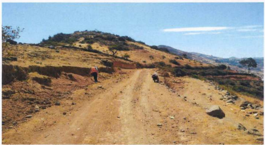
Fotografía 10: Replanteo de medidas del ancho del camino vecinal.
