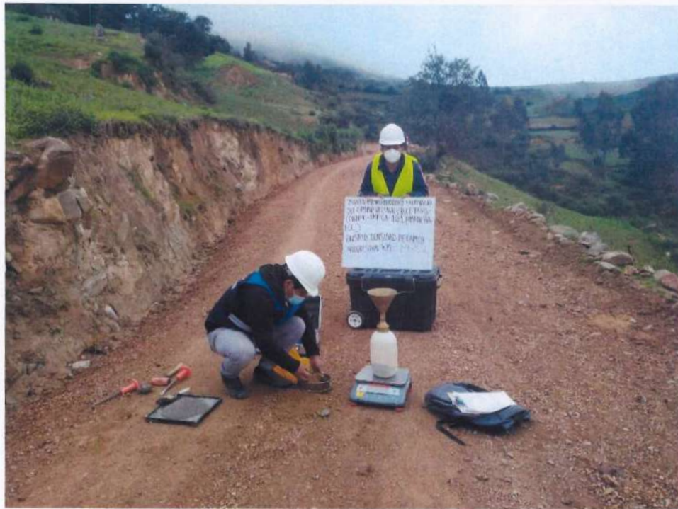
Fotografía 127. Densidad de campo el km 14+250.
