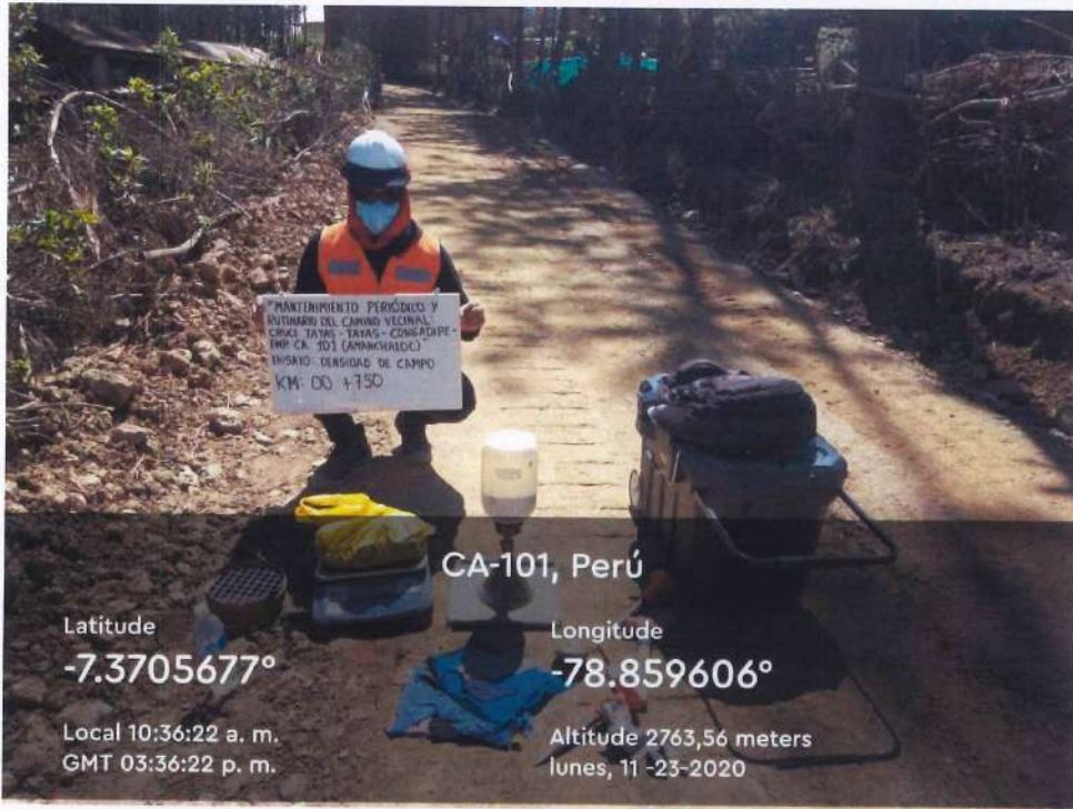
Fotografía 57. Densidad de campo el km 00+750.
