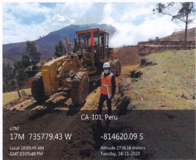
Fotografía 47. Motoniveladora realizando trabajos de extendido de material granular en la vía.
