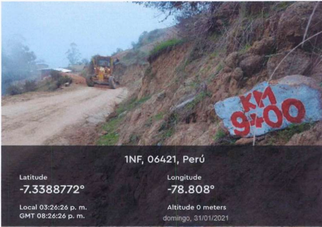
Fotografía 67. Motoniveladora realizando trabajos de extendido de material granular en la vía.
