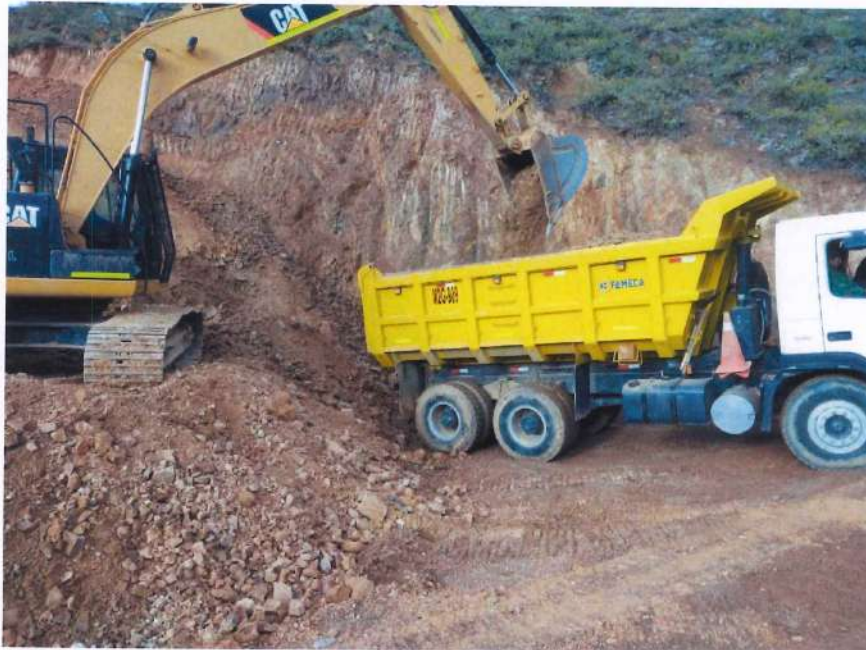
Fotografía 64. Carguío de material granular para afirmado.
