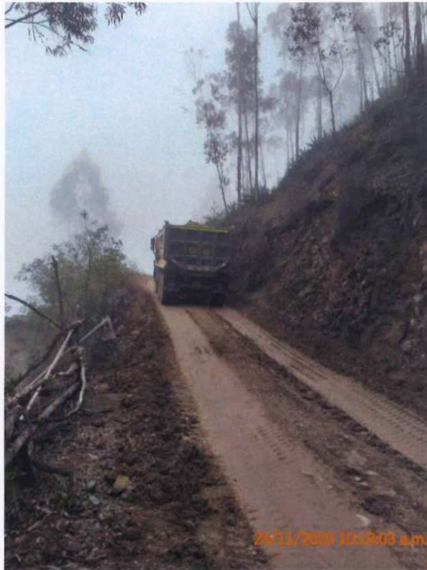
Fotografía 50. Transporte de material excedente.
